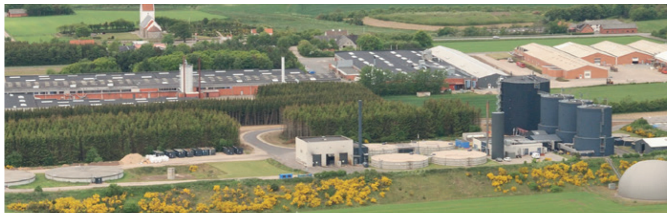
Biogasanlæg ved Lemvig
